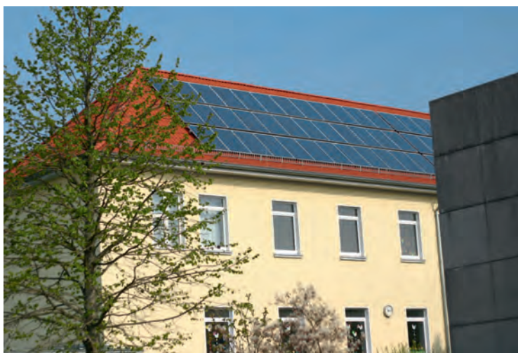
Die Solaranlage auf dem Dach der Theodor-Heuss-Schule in Empelde: Bürgerinnen und Bürger investieren in erneuerbare Energie – ein gutes Invest in unser aller Zukunft!
